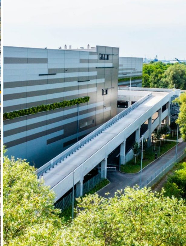
Exemple d'une rampe pour camions sur le site de FourParx « Mach2 » en Allemagne.
