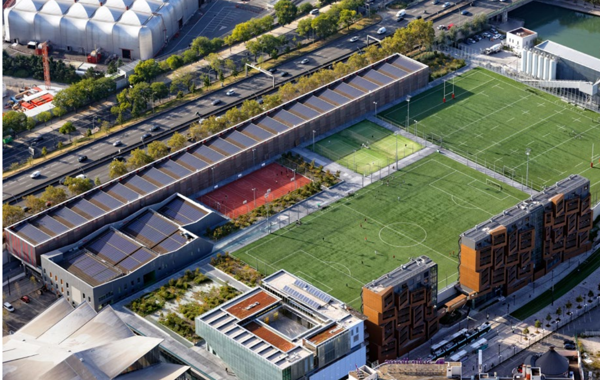
Terrains de sport sur la toiture du centre de maintenance du Tramway T3, Porte de Pantin , Paris 19e.
