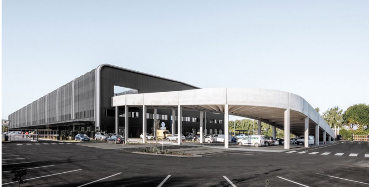
Matrice, Lille Métropole - Hôtel logistique – vue de la rampe donnant accès à la cour camion de l'été.
